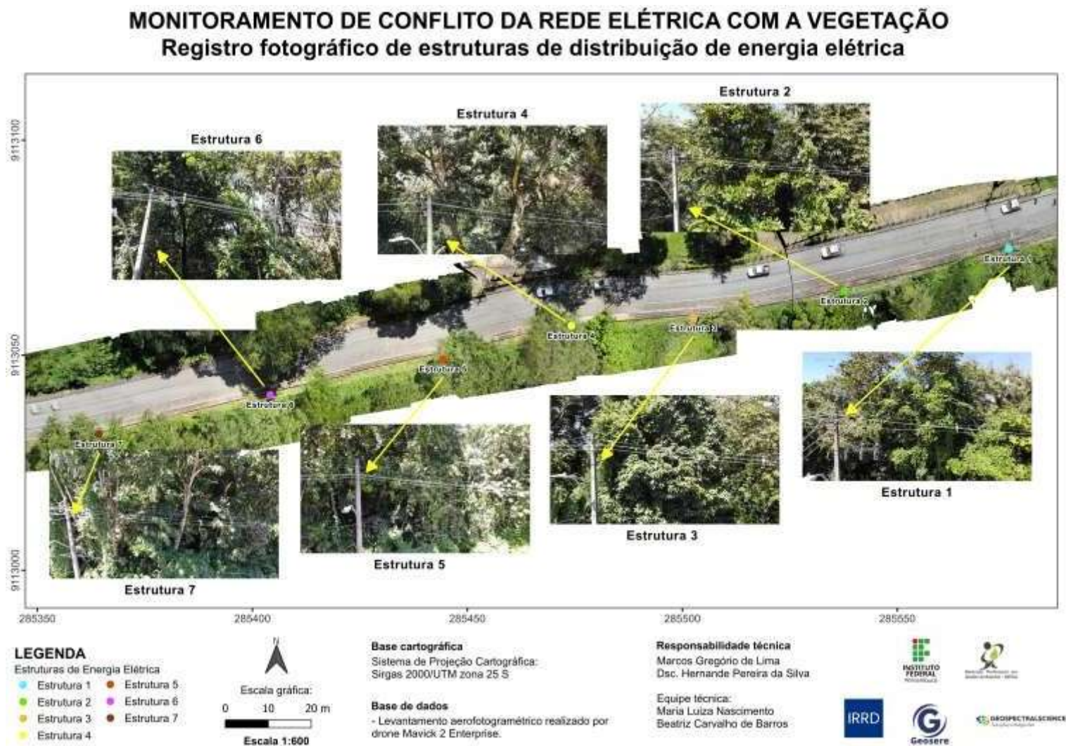
Imagem 25. Monitoramento de Conflito da rede elétrica com a vegetação. Estruturas
