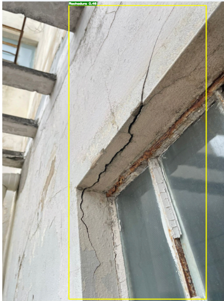
Figura 3 - Exemplo do bounding box gerado pelo YOLO para detectar rachaduras e indicar o nível de acerto.
