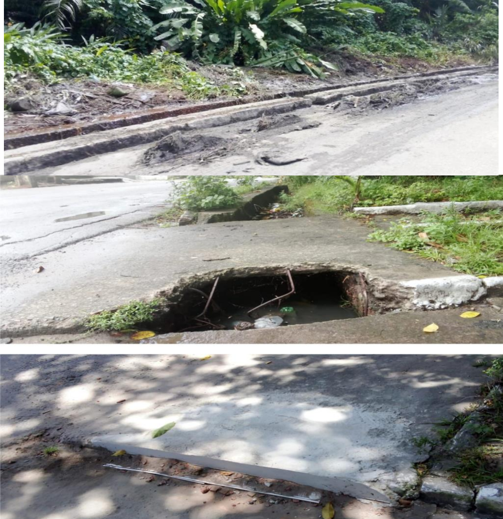
Figura 23 - Limpeza das Canaletas Perimetrais da FURB Mata do Passarinho
