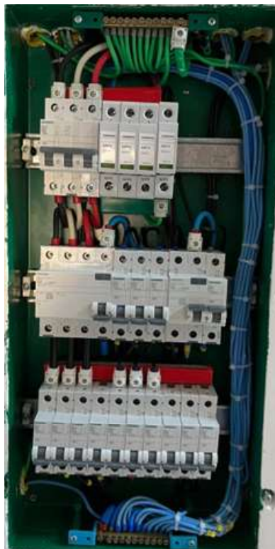
Figura 3 – Quadro elétrico após readequação com DR e DPS.
