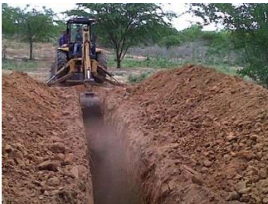
Figura 3 - Escavação mecanizada pela metodologia VCA. (Fonte: HC Panini, 2025).
