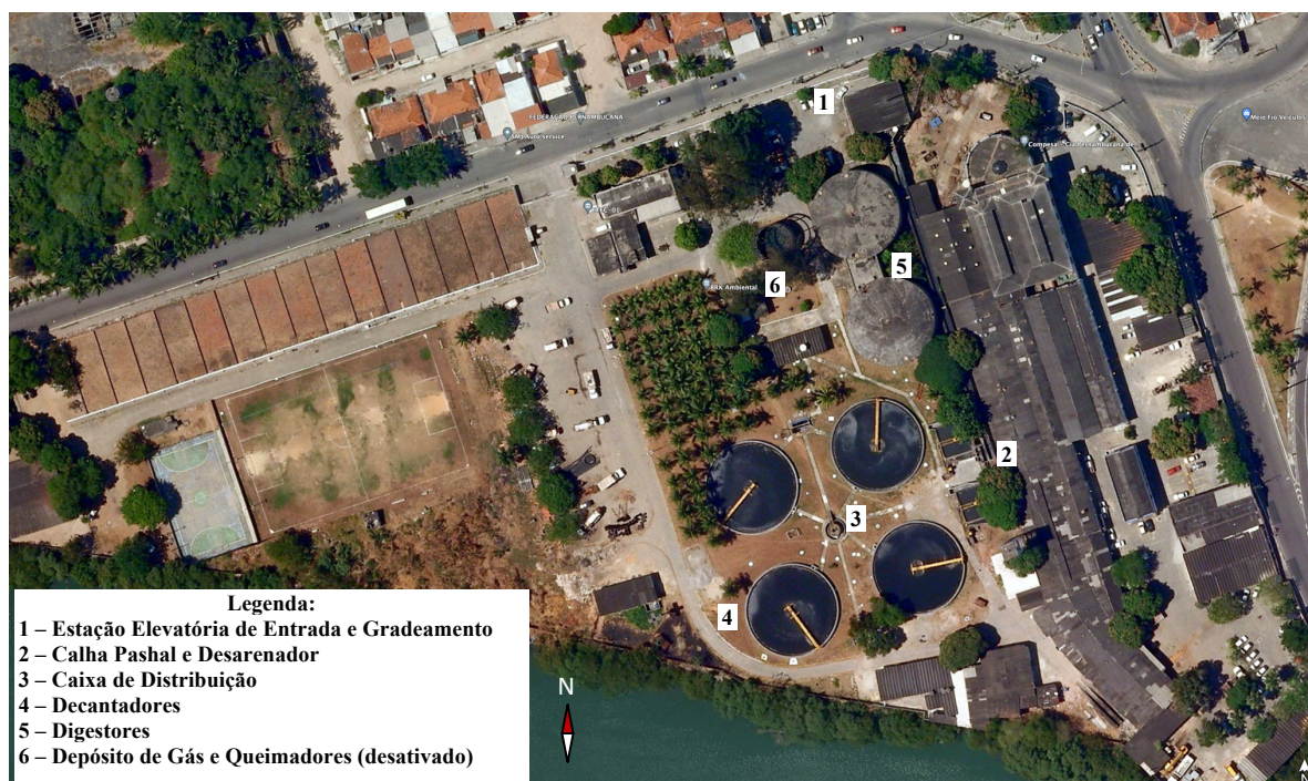
Figura 6.3 – Vista Superior da Estação de Tratamento de Esgotos Cabanga
