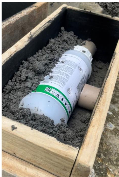
Figura 16 - Preenchimento dos blocos de concreto.
