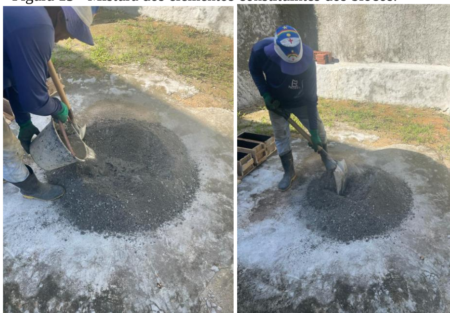
Figura 13 - Mistura dos elementos constituintes dos blocos.
