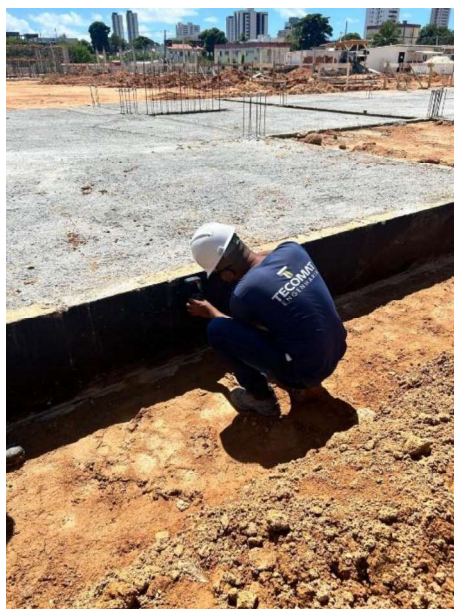
Figura 8 – Verificação da armação com o auxílio do pacômetro
