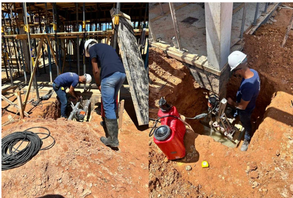
Figuras 9 e 10 – Equipamento acoplado realizando a extração de testemunho de concreto
