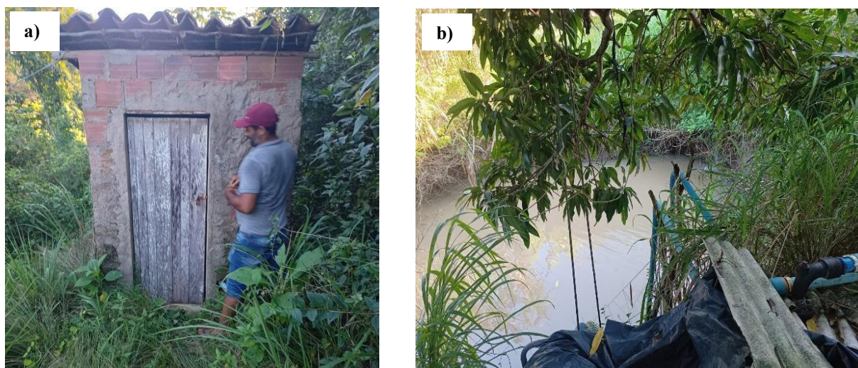
Figura 27: Local onde está instalada a primeira bomba utilizada para captação de água (a); local de instalação da segunda bomba de captação de água (b)
