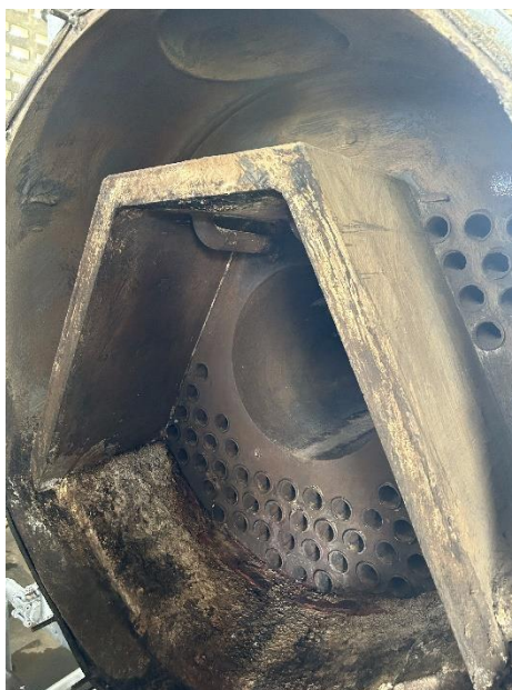
Figura 3.14. Espelho traseiro e alteração realizada na caldeira. Fonte: Autoria Própria (2023).
