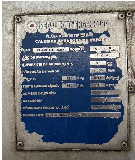
Figura 3.1. Placa de identificação da Caldeira. Fonte: Autoria Própria (2023).
