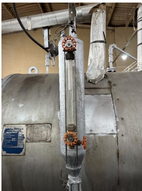
Figura 3.8. Visor de nível. Fonte: Autoria Própria (2023).
