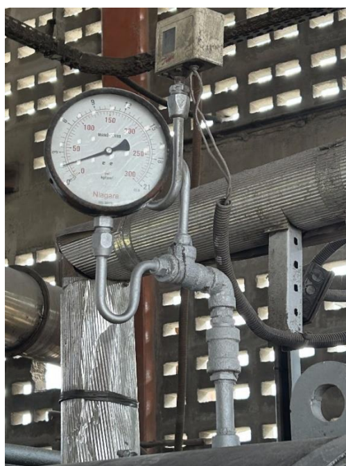
Figura 3.10. Manômetro e Pressostato. Fonte: Autoria Própria (2023).
