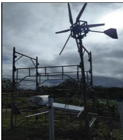
Figura 20. Montagem do micro aerogerador
