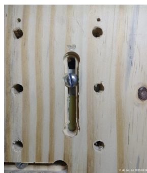
(b) Detalhe da ranhura para ajuste dos parafusos.
