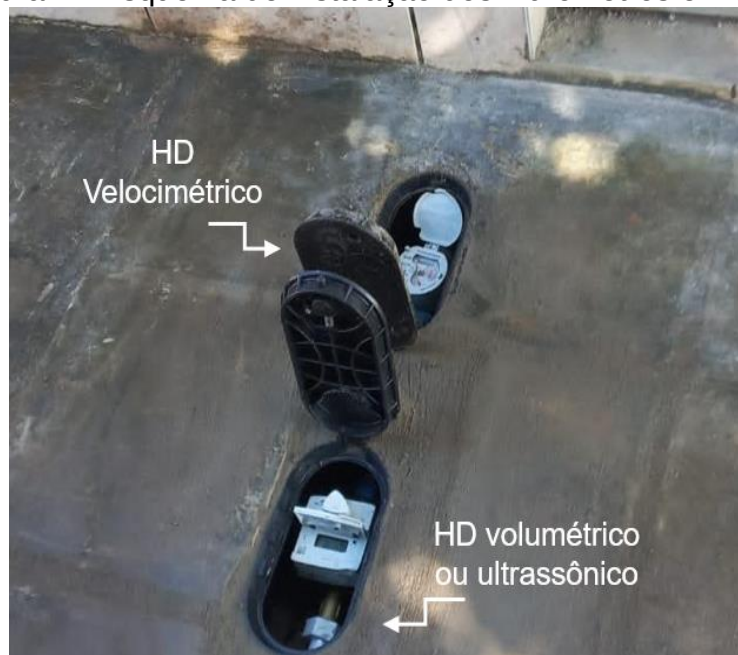
Figura 1 - Esquema de instalação dos hidrômetros em série
