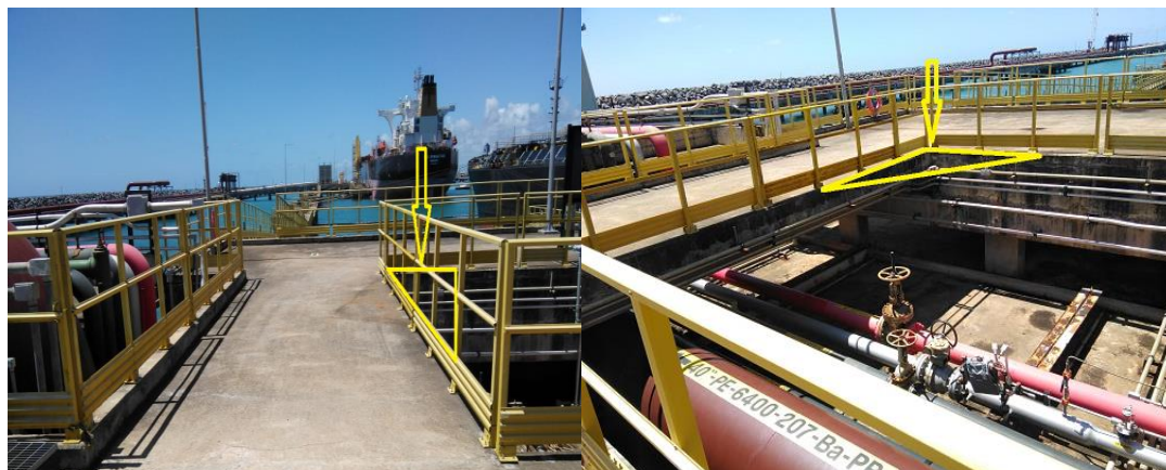
Figura 9 PGL 3B Suape. (a) Parte do PGL 3B (b) local onde vai ficar a estrutura metálica.
