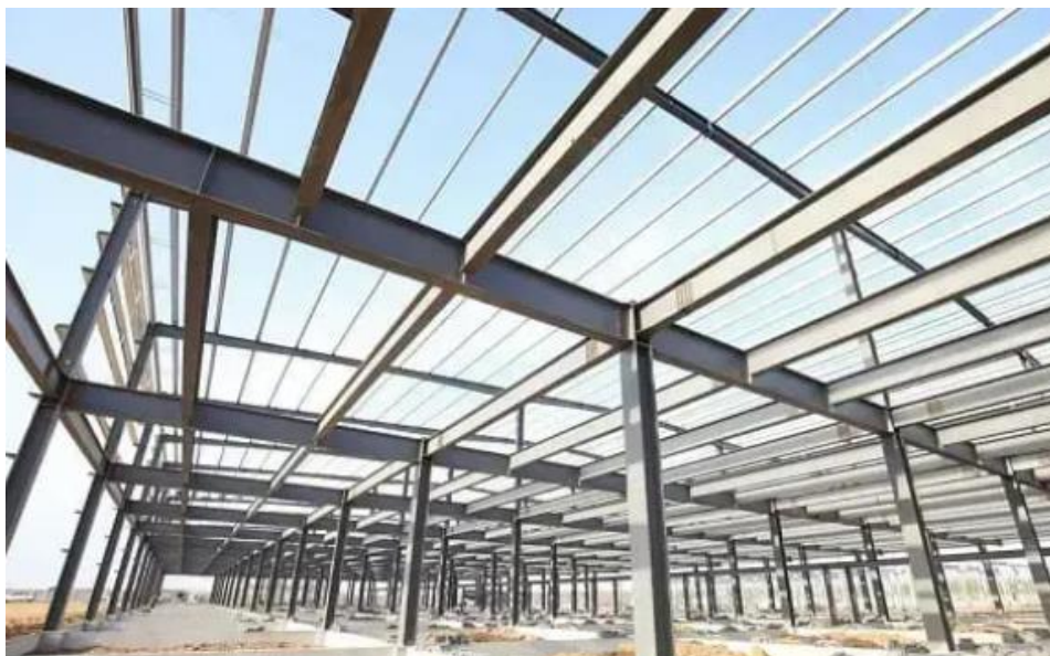
Figura 5 Exemplo de estrutura metálica
