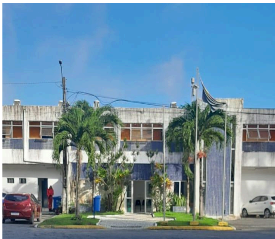
Figura 2 - Fachada do prédio onde se estabelece a sede da Diretoria Limpeza Urbana (DLU)
