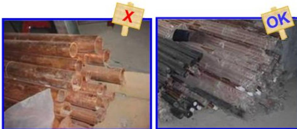
Figura 19. Armazenamento dos materiais.
