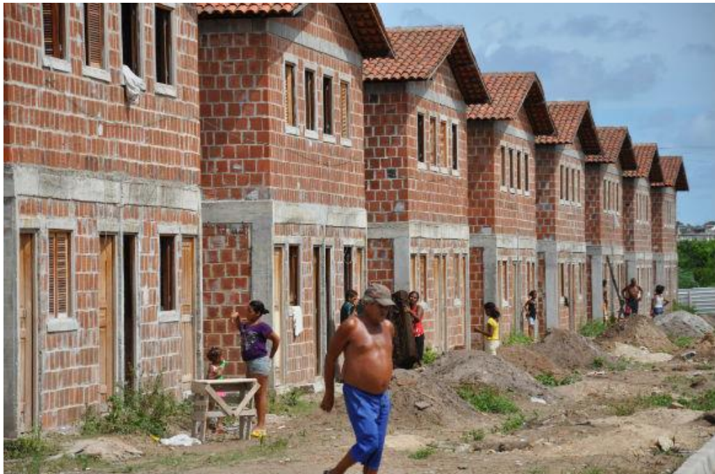
Foto 4 - Vista da entrega da primeira etapa de construção do conjunto habitacional, abril de 2014
