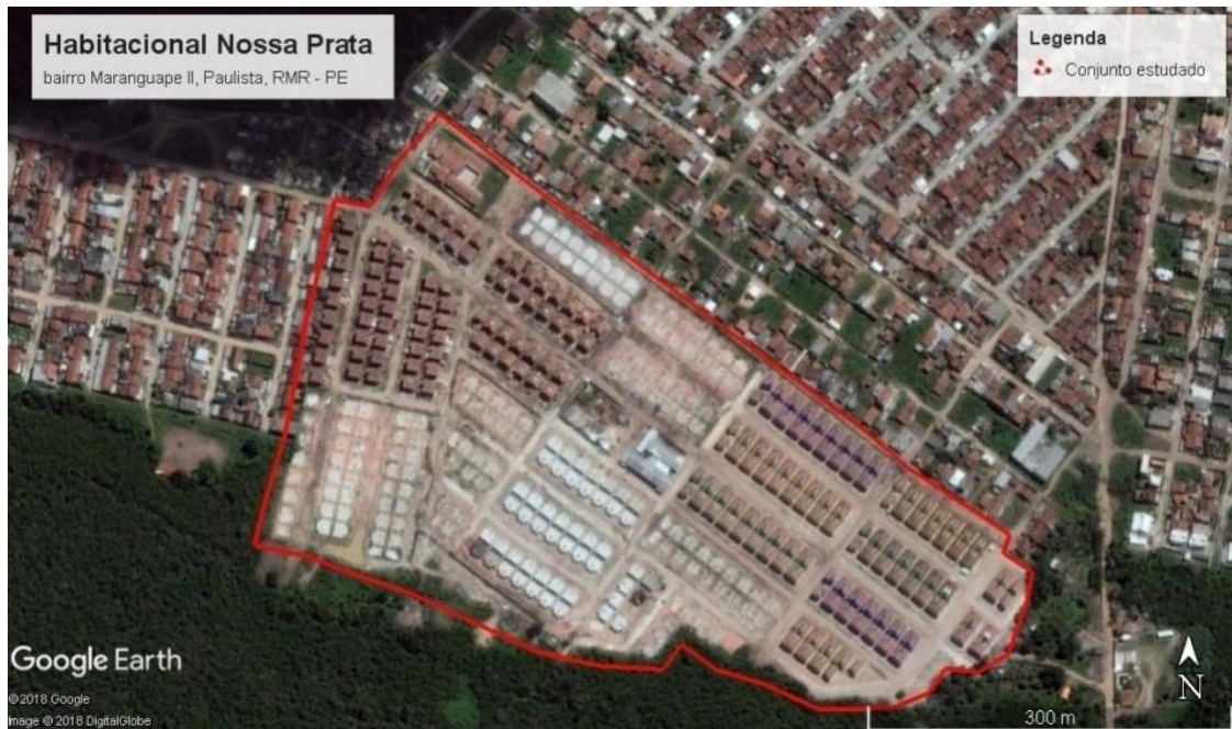
Figura 3 - Vista aérea da área do conjunto habitacional, final da obra da primeira etapa, 2014
