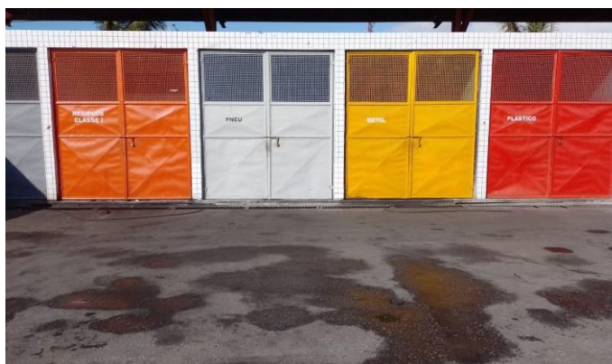
Figura 2 - Central de resíduos
