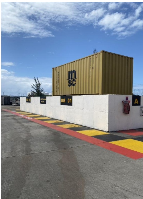
Figura 5 –Tanque de Contenção
