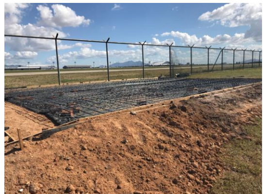
Figura 14: Laje de fundação em radier, Base Aérea de Fortaleza, Fortaleza – CE
