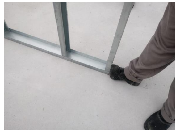
Figura 04: Bloqueador utilizado em montagem de estrutura em LSF, Bonanza LSF, Vitória de Santo Antão - PE
