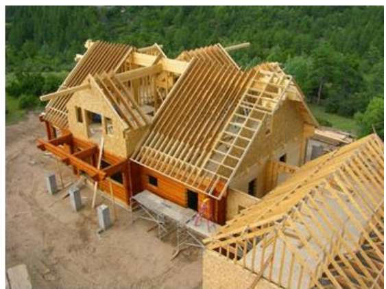
Figura 01: Construção em Wood Frame
