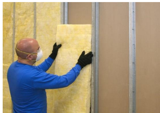
Figura 03: Instalação de Lã de Vidro em painéis.
