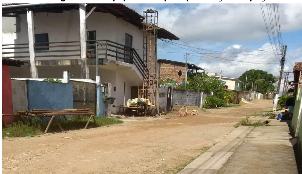
Figura 16 – Equipamento para perfuração de poço
