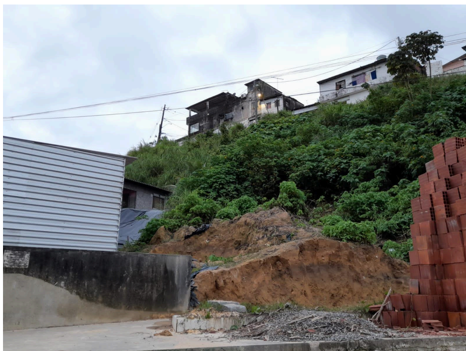
Figura 32 - Cicatriz de deslizamento em uma barreira na localidade de Lagoa Encantada.
