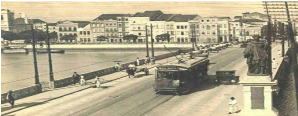
FIGURA 16 – Bonde elétrico atravessando a ponte Maurício de Nassau
