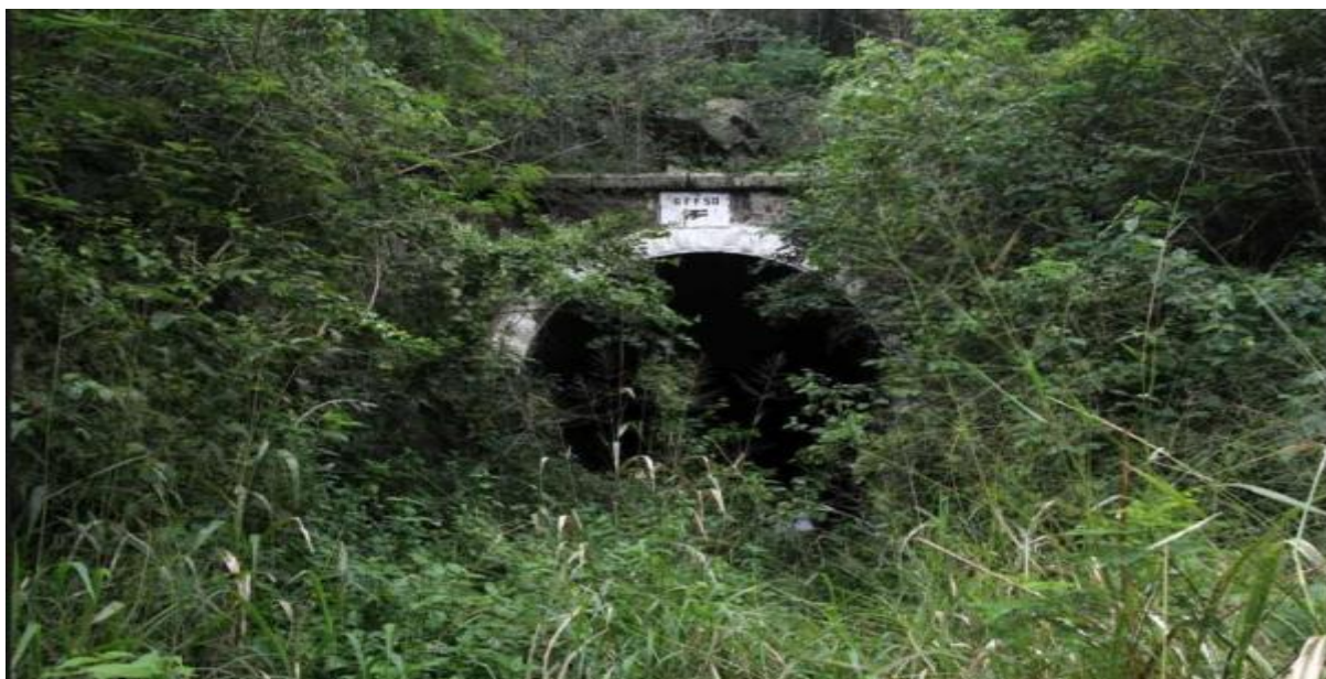
FIGURA 24 - Túnel Ferroviário Cascavel – Gravatá – PE
