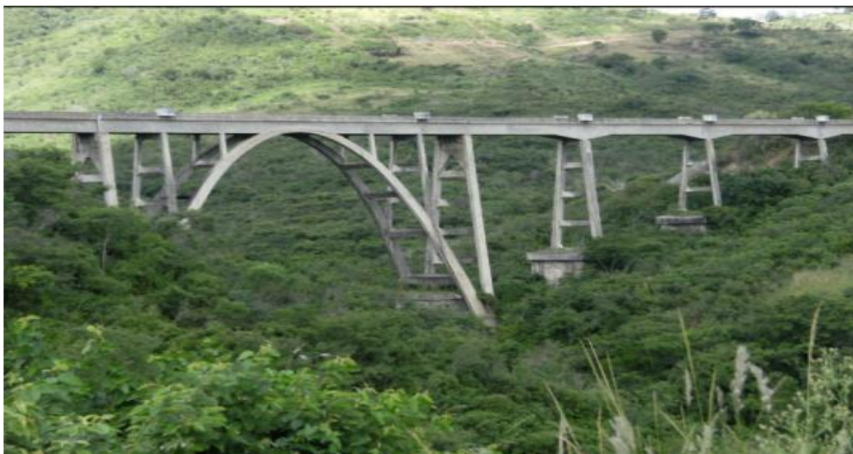
FIGURA 23 - Ponte Ferroviária Cascavel – Gravatá – PE
