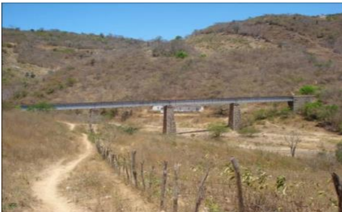
FIGURA 25 - Ponte Ferroviária na Vila de Freixeira – Período de Seca
