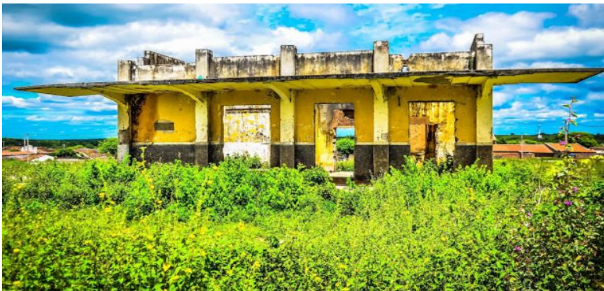
FIGURA 12 – Estação de Albuquerque Né abandonada
