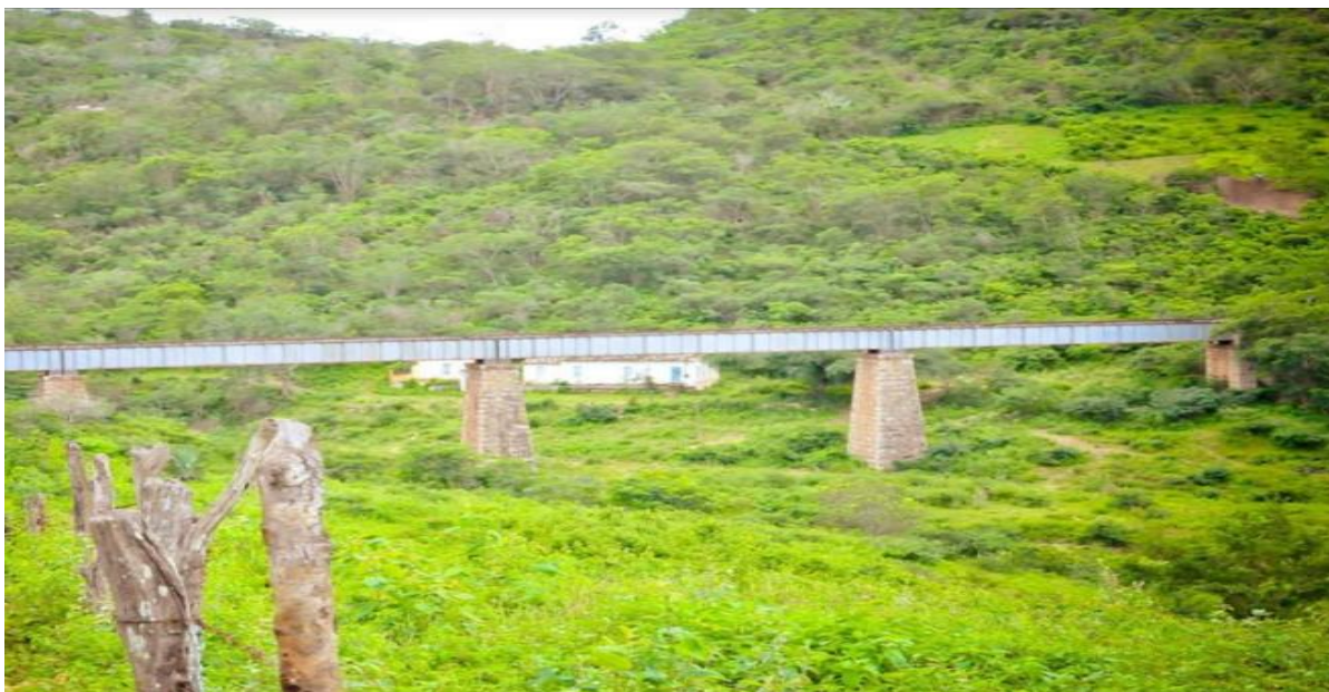
Ponte ferroviária em Freixeira Velha sobre o rio Ipanema no distrito de Mimoso em Pesqueira no Agreste Pernambucano – FONTE: Projeto Memória Ferroviária de Pernambuco, 2011.
