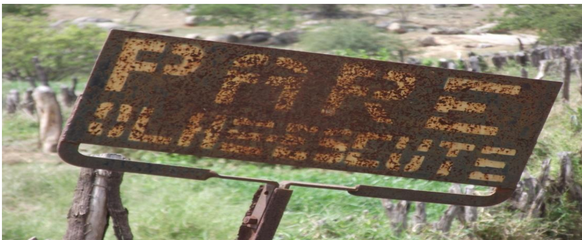
FIGURA 32 - Placa de sinalização na rodovia PE 365 em Serra Talhada
