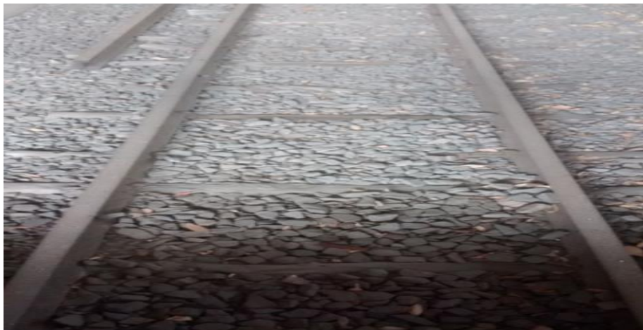
Construção original de 1885 com dormentes de madeira no Museu do Trem de Pernambuco. Foto: autor 2018.
