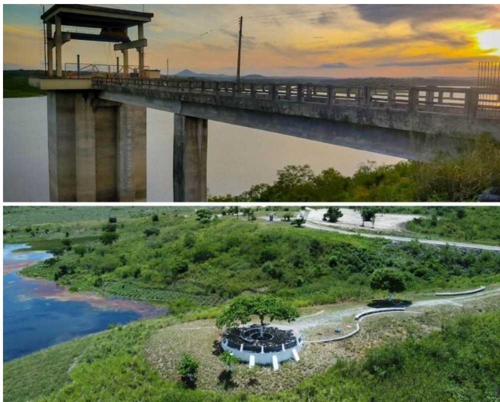
Figura 3 - Barragem de Lagoa do Carro
