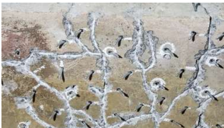
Figura 05 – Fixação dos Bicos de Perfuração nos Blocos
