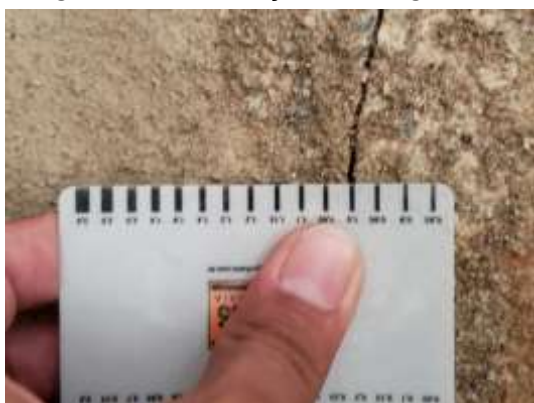
Figura 03 – Medição da largura da fissura.
