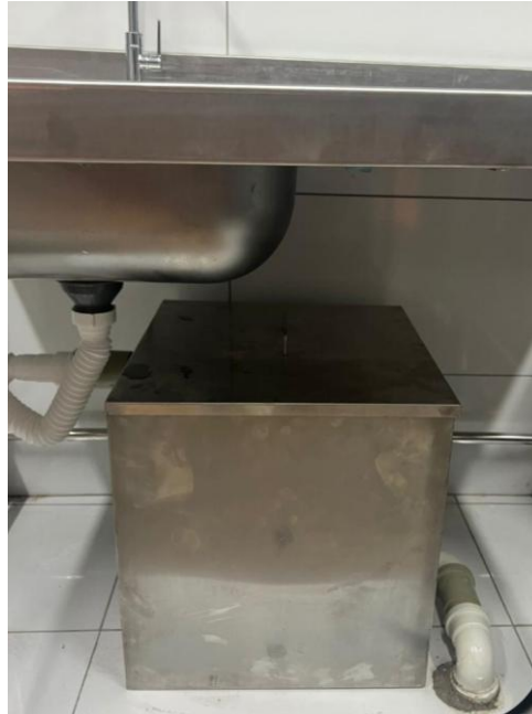
Figura 04: Caixa de gordura instalada.
