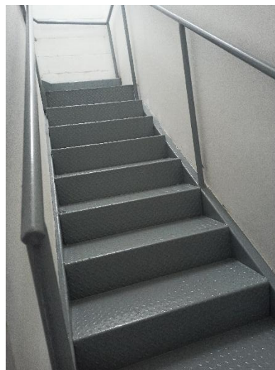
Figura 07: Escada metálica ampliada para atender exigências do CBM.
