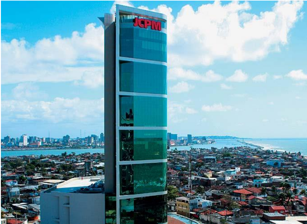
Figura 4 - Edifício JCPM Trade Center, situado no bairro de Brasília Teimosa, em Recife
