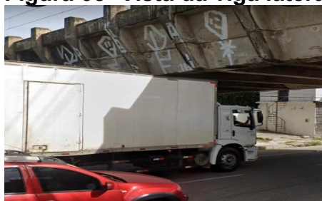
Figura 05- Vista da viga lateral
