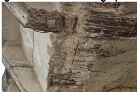
Figura 06 – Vista da viga parte inferior
