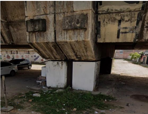
Figura 09 – Vista dos pilares e vigas
