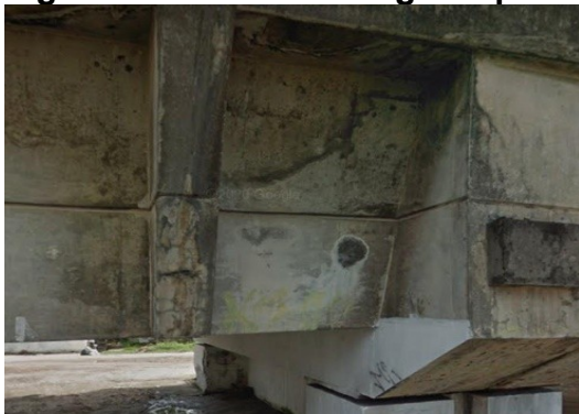
Figura 07 – Vista das vigas e pilares
