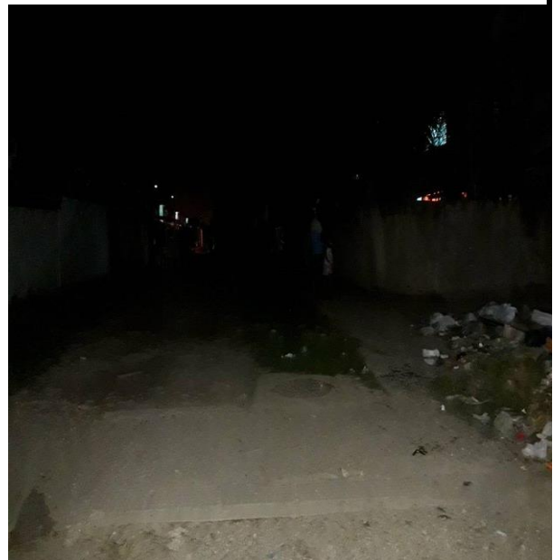
Fotografia 22 – Iluminação deficiente à noite no Conjunto Habitacional Novo Redentor
