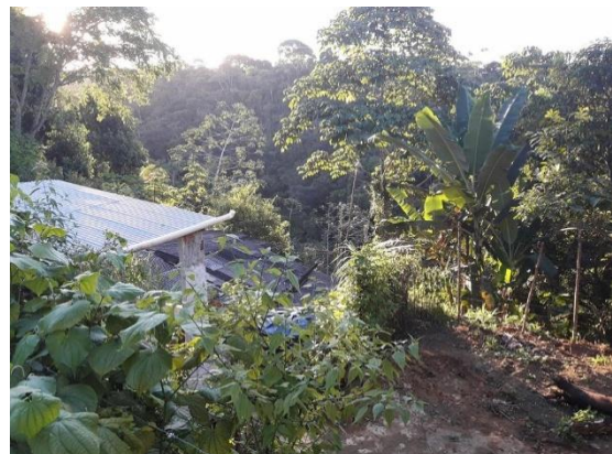
Fotografia 39 – Residência nova em área de risco
