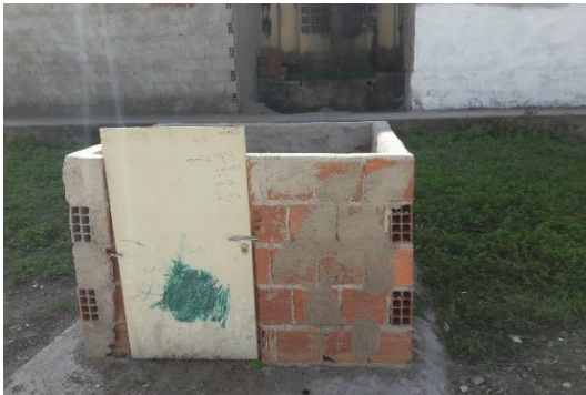
Fotografia 28 – Coletor de resíduos sólidos improvisado pelos moradores no Conjunto Habitacional Novo Redentor
