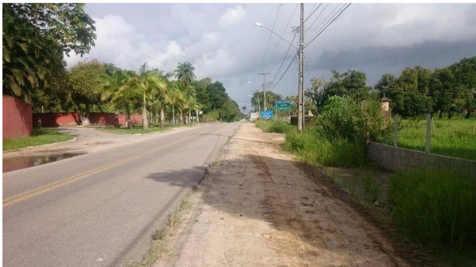
Fotografia 1 – Trecho da Estrada de Aldeia especialmente nas imediações do km 13
