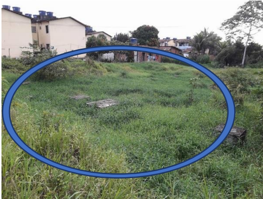
Fotografia 24 – Terreno encharcado onde ficam as fossas (em destaque) que recebem todo o esgoto, e drena diretamente para o rio das Pacas
