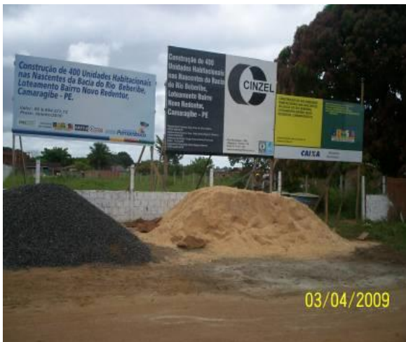
Fotografia 14 – Canteiro de obra: início da implantação do Conjunto Habitacional Novo Redentor no bairro de Vera Cruz em Aldeia
