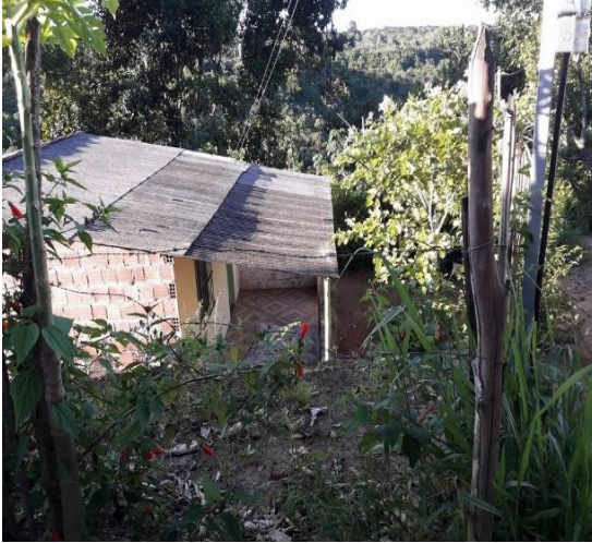
Fotografia 40 – Outra residência nova em área de risco
