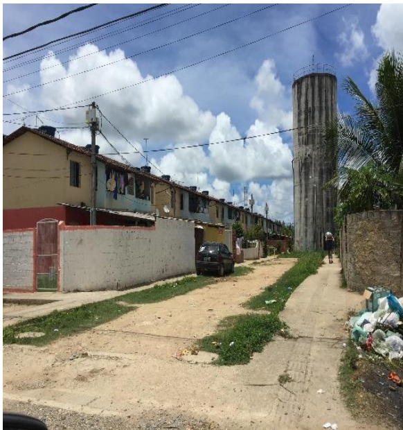
Fotografia 21 – Claridade diurna na rua do Conjunto Habitacional Novo Redentor
