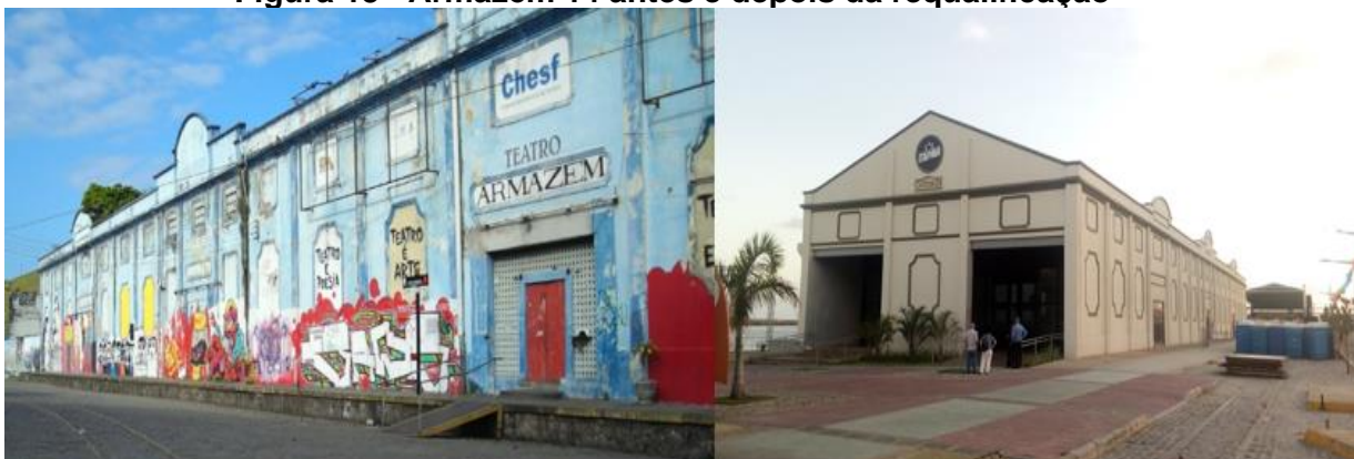
Figura 13 - Armazém 14 antes e depois da requalificação
