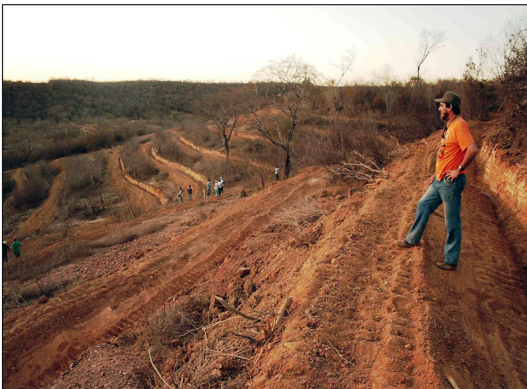
Figura 38: Canais de infiltração de água
