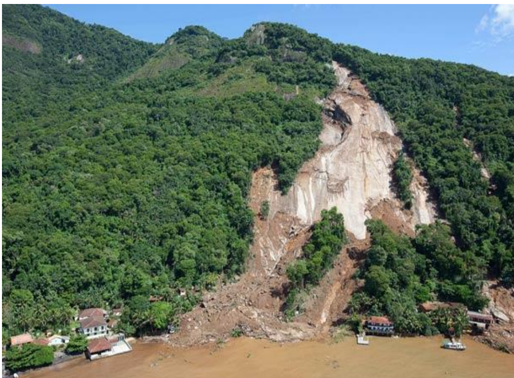
Figura 37: Erosão facilitada pelo declive da topografia
