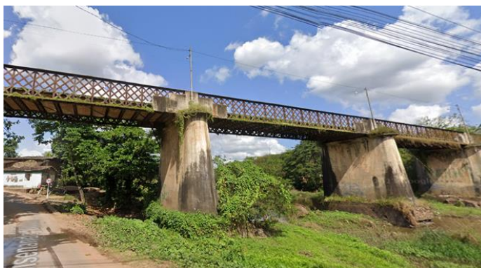
Figura 11 - Ponte do Itaíba
