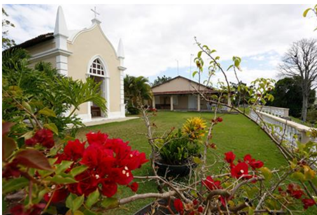
Figura 2 - Casarão e Capela do Engenho São Bernardo
