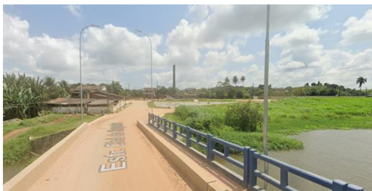
Figura 3 - Vista da Ponte do Antigo Engenho e Usina Mussurepe
