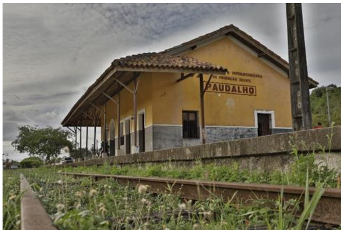
Figura 10 - Estação Ferroviária - Sede
