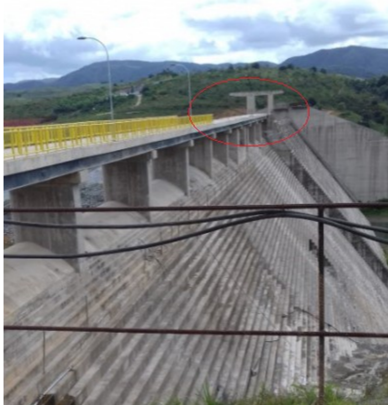
Figura 32 - Parte frontal da barragem com destaque ao trecho em construção.
