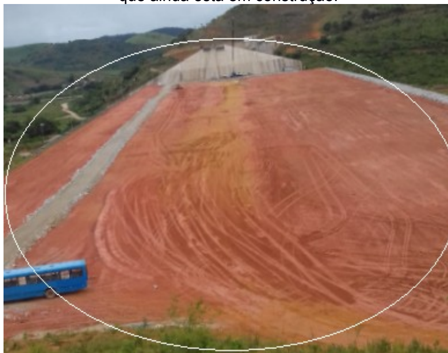
Figura 33 - Visão lateral da barragem, em destaque a área da barragem de terra que ainda está em construção.
