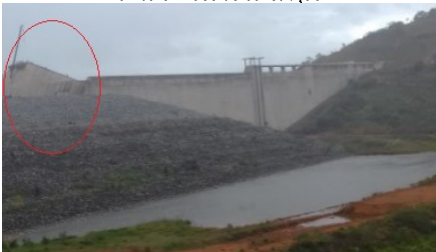
Figura 34 - Imagem total da barragem com destaque a parte da barragem de terra ainda em fase de construção.
