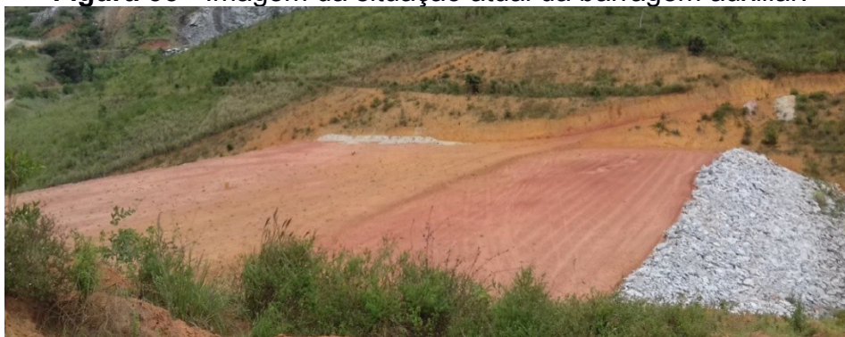
Figura 35 - Imagem da situação atual da barragem auxiliar.
