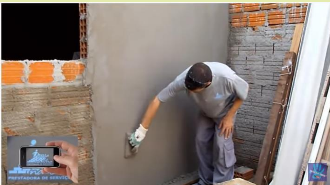
COMO FAZER REBOCO
