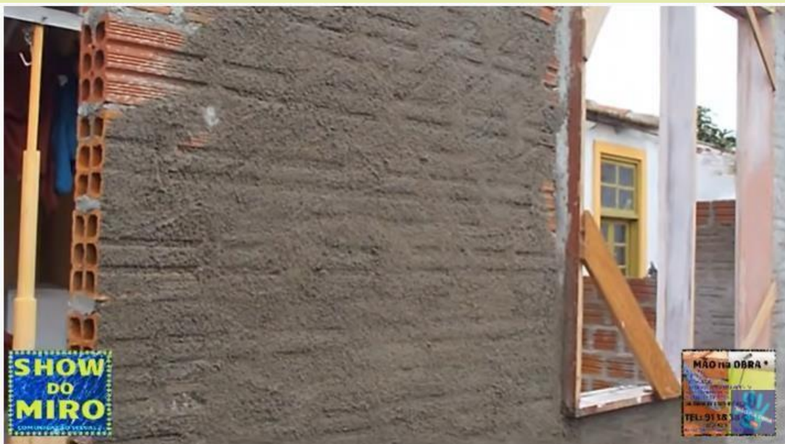
COMO CHAPISCAR UMA PAREDE.,,MÃO NA OBRA
