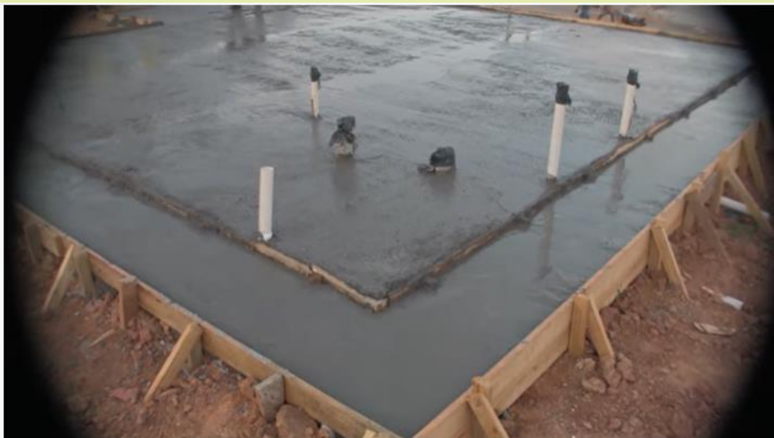
FUNDAÇÃO RADIER - STEEL FRAME
