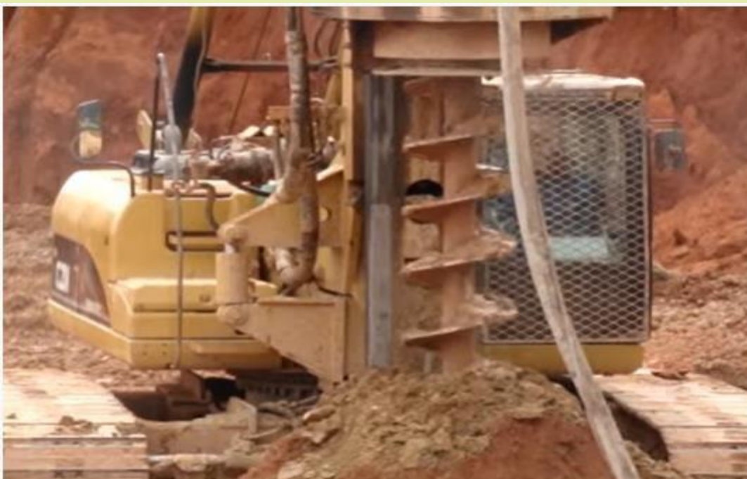
Fundação em Estacas Hélice Contínua
