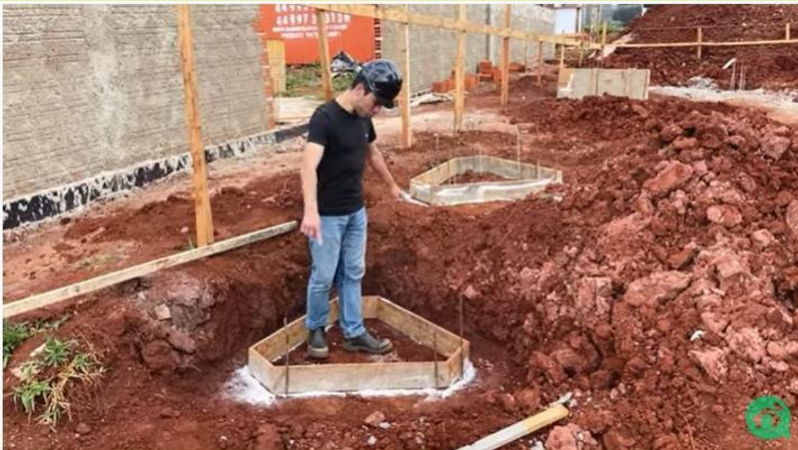
Bloco de Fundação com 1, 2, 3 e 4 Estacas Escavadas
