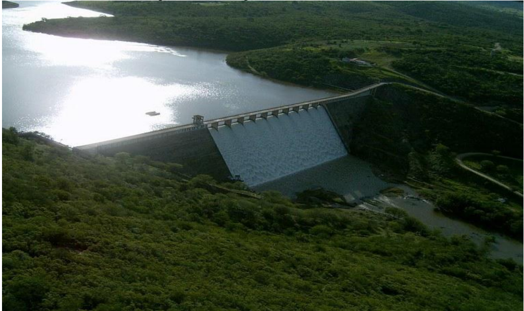
Figura 8 – Barragem de Jucazinho
