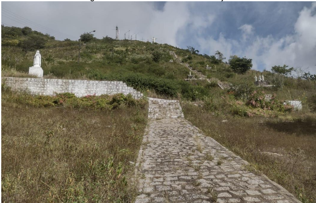
Figura 25 - Trecho antes da revitalização
