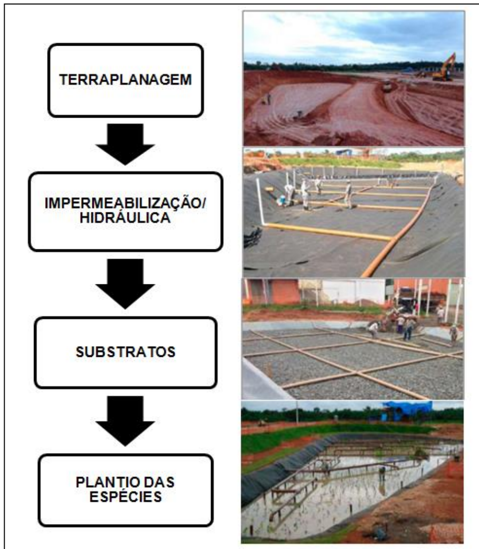
Figura 12 - Sequência das etapas construtivas do Jardim Filtrantes®
