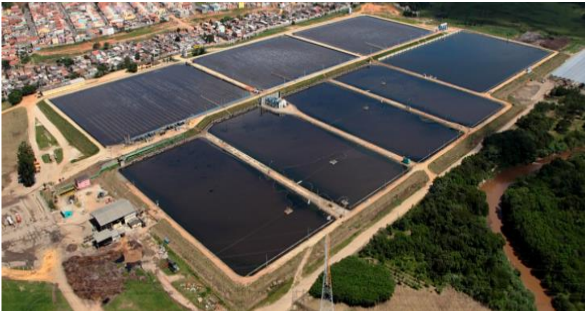
Figura 1 - Lagoas de estabilização da ETE de Jundiá
