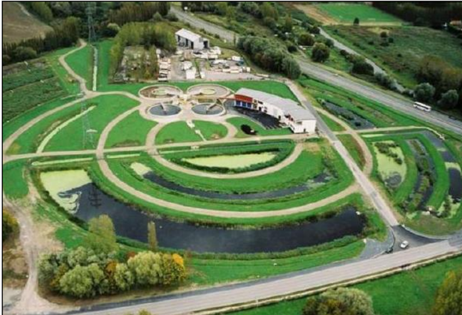
Figura 10 - Tratamento de esgoto urbano de médio porte com Jardins Filtrantes®
