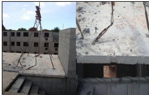
Figura 9: Laje sendo apoiada sobre alvenaria com cordão de massa
