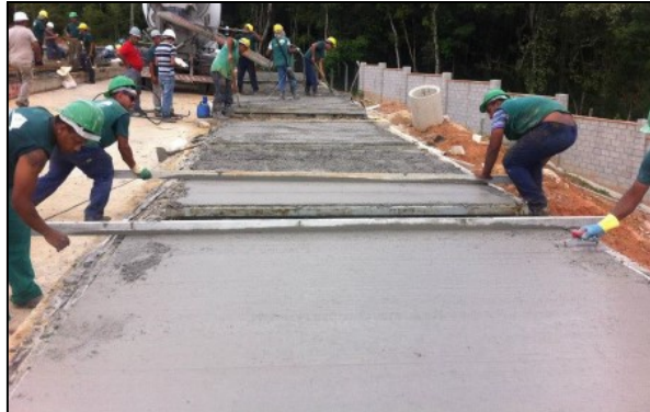
Figura 8: Concretagem da laje
