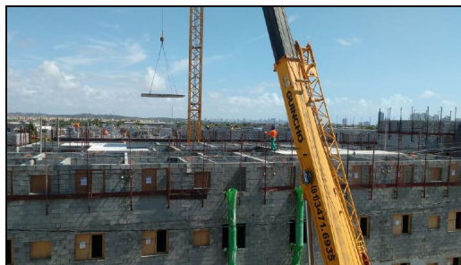
Figura 10: Laje sendo içada pelo munck
