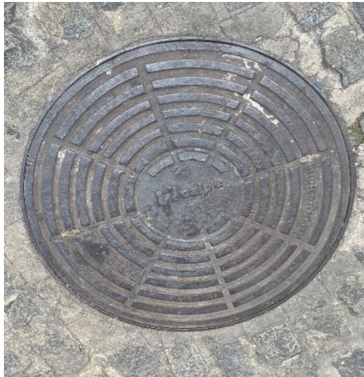
Figura 12 – Tampa de bueiro instalada pela CELPE na Rua do Bom Jesus
