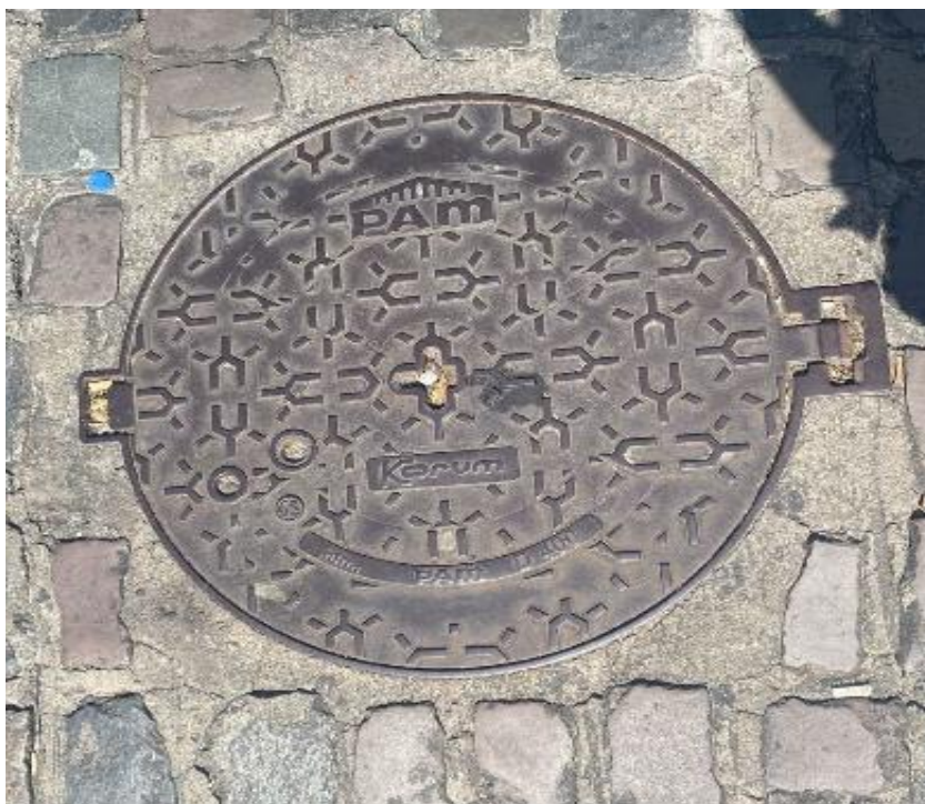
Figura 2 – Tampa de bueiro instalada na Rua da Guia pela PAM
