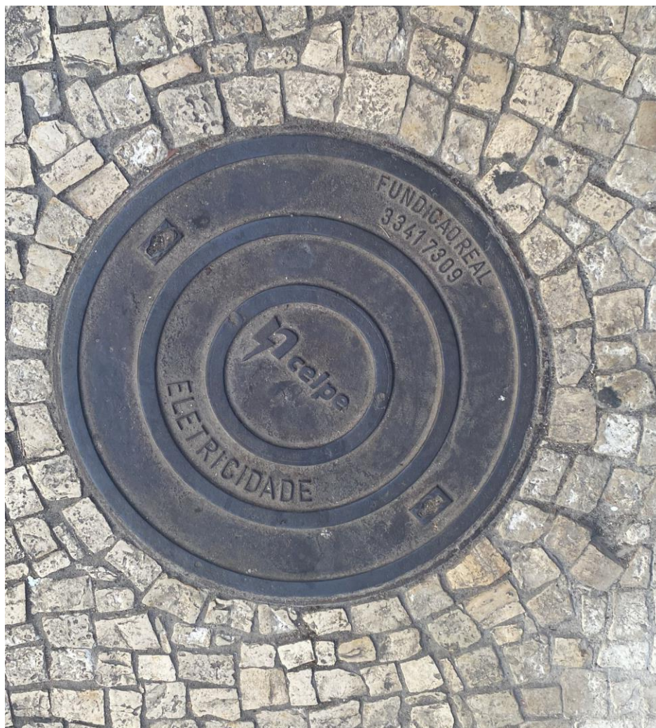
Figura 15 – Tampa de bueiro, instalada na Rua do Apolo sem referência de empresa responsável.
