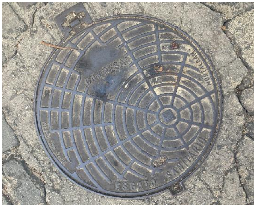
Figura 6 – Tampa de bueiro, instalada na Rua Dona Maria César pela Montalbam
