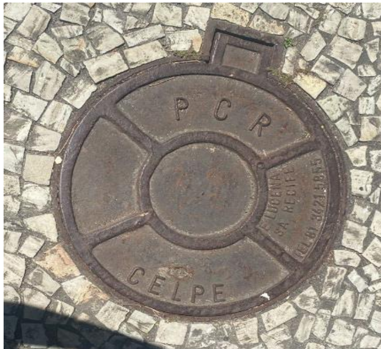
Figura 11 - Tampa de bueiro, instalada pela CELPE na Rua da Moeda
