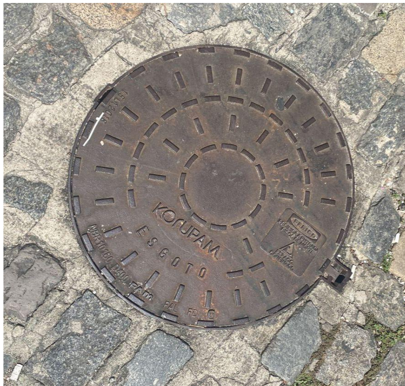
Figura 3 – Tampa de bueiro instalada na Rua do Apolo pela PAM
