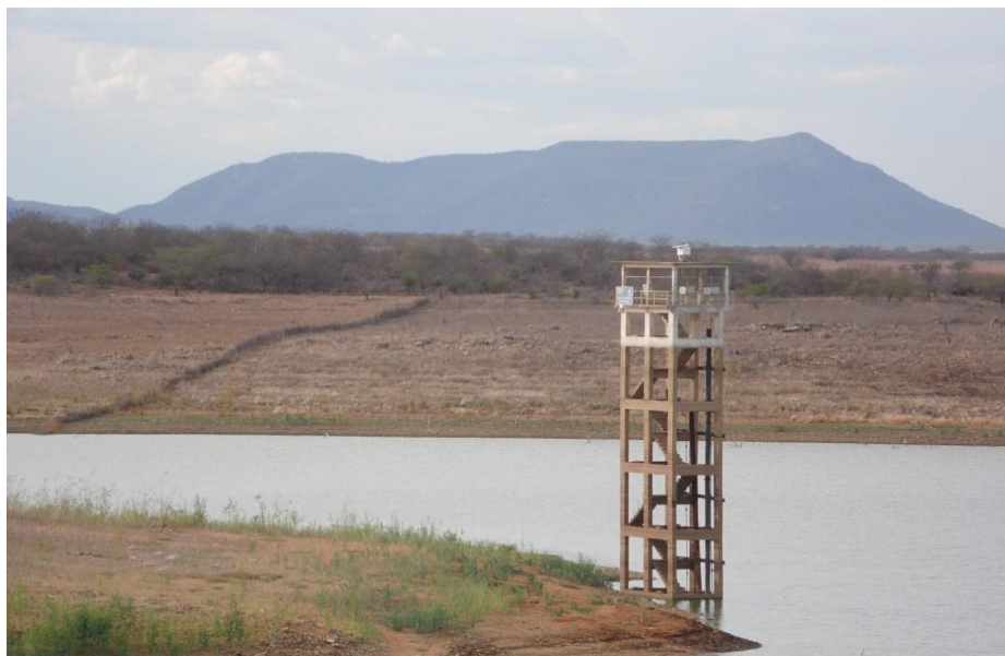
Figura 15 – Açude Poço da Cruz, localizado em Ibimirim, PE.
