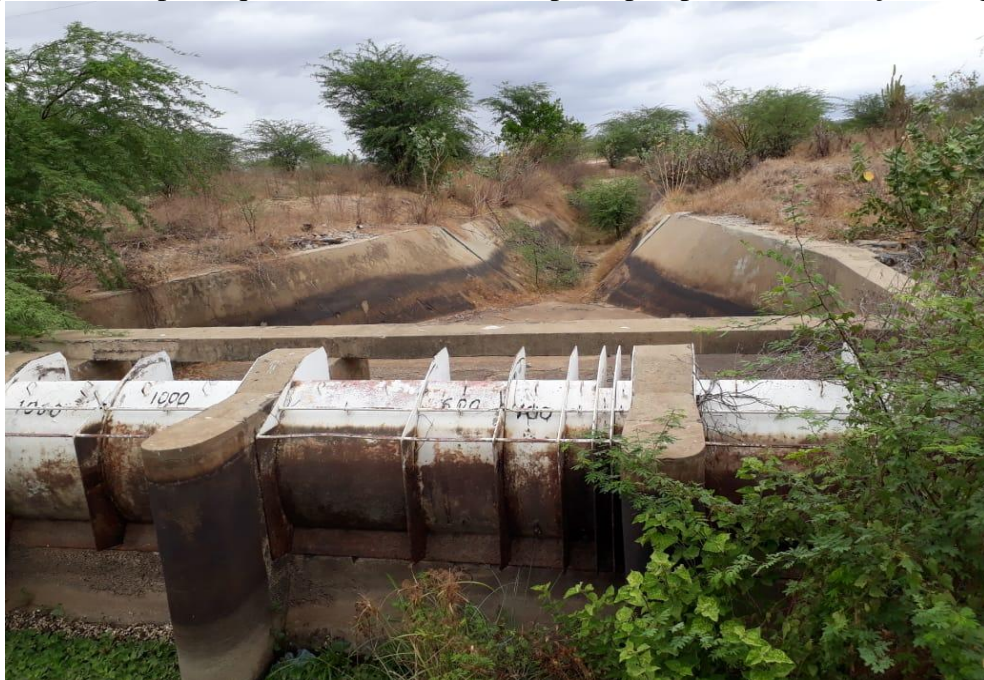
Figura10: Comporta que dá acesso à canaleta principal, para a distribuição de água.
