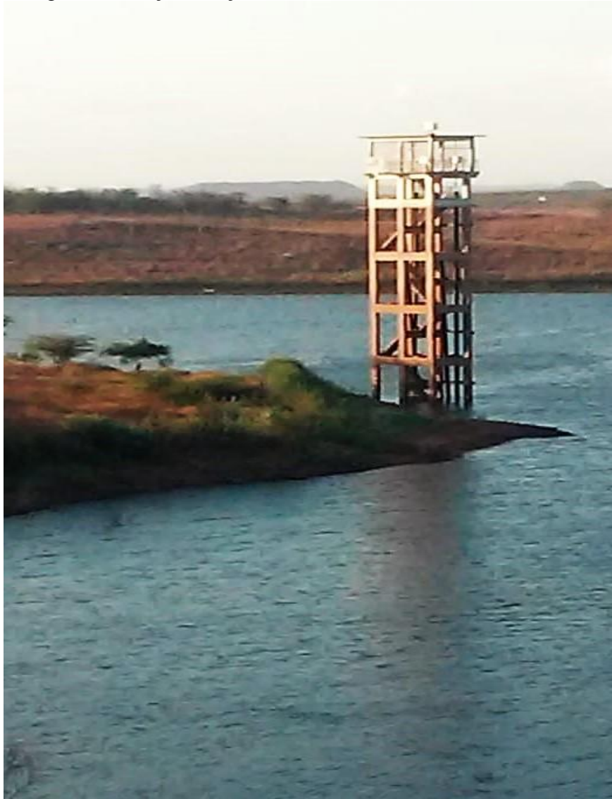
Figura 26 – Açude Poço da Cruz, localizado em Ibimirim, PE.
