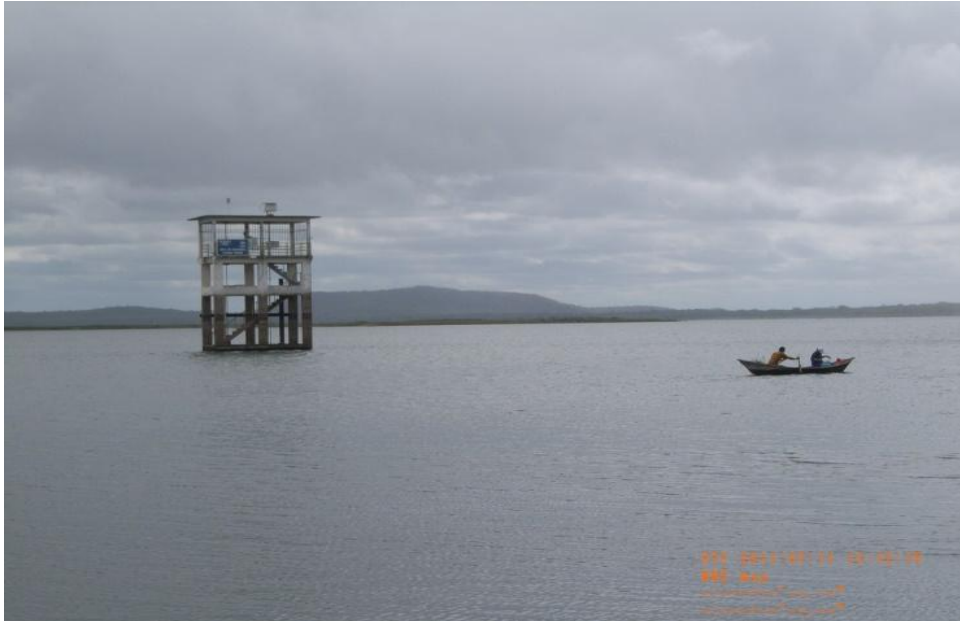
Figura 14 – Açude Poço da Cruz, localizado em Ibimirim, PE.
