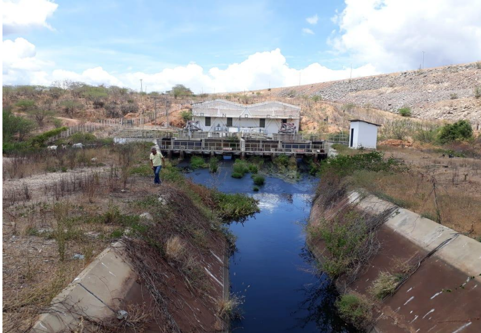
Figura 9 – Estação da Celpe, por onde passa a água do reservatório Poço da Cruz, para abastecer o PIMOX.
