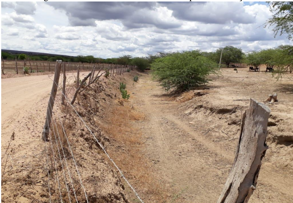
Figura 12 - Canaleta do PIMOX sem impermeabilização.
