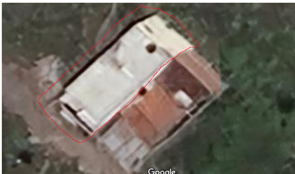
Figura 36 – Vista 3D gerada no google map
