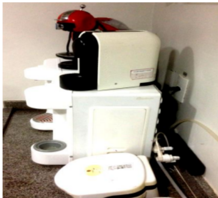
Figura 3 – Adaptadores de tomada em uso permanente por vários eletrodomésticos.
