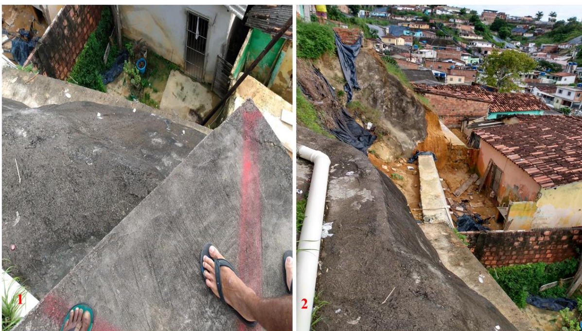
Figura 20: Parte das Barreiras cimentadas pelos moradores no setor 10 do Bairro da Linha do Tiro – Recife
