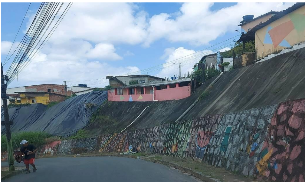
Figura 29 - Área com muro de arrimo e com lona para proteção
