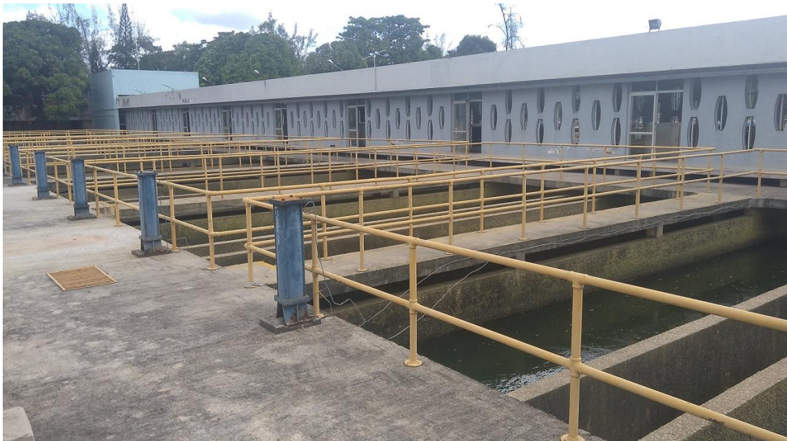
Figura 23 - Filtros; Filtros em operação.
