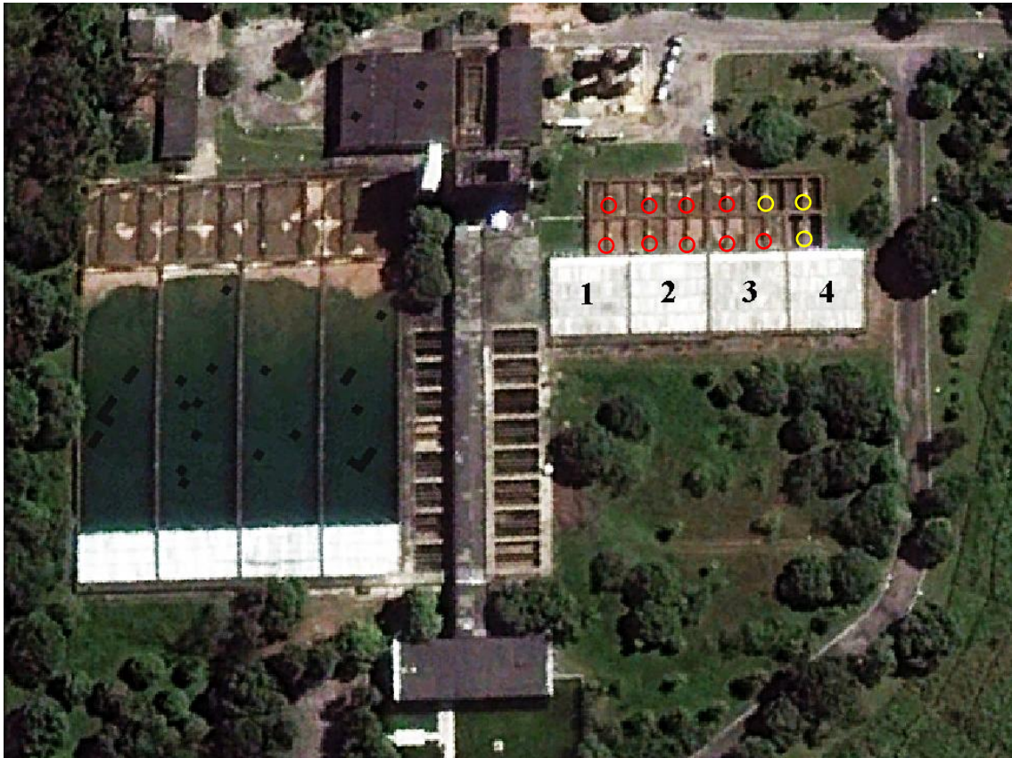
Figura 32 – Decantadores tubulares – (1, 2, 3, 4) e floculadores (vermelho e amarelo); Limpeza do decantador (4), juntamente com 03 floculadores (amarelo).
