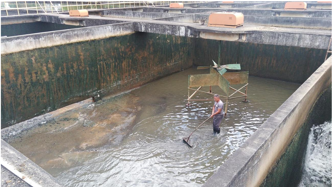
Figura 26 - Limpeza do floculador.
