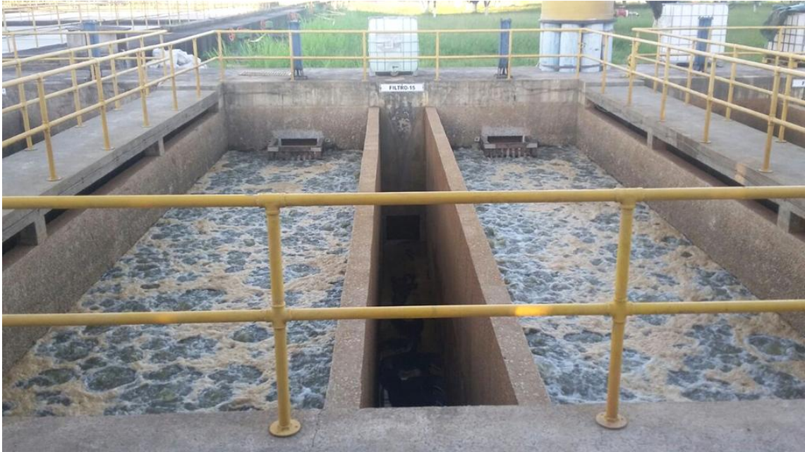
Figura 28 - Injeção de ar comprimido para desagregação do lodo no filtro.
