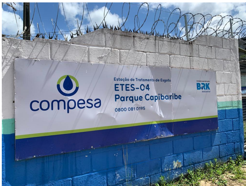
Figura 09 – Entrada da ETE Parque Capibaribe
