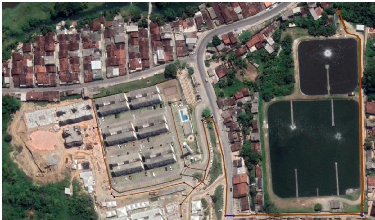
Figura 05 - Emissário da obra até a ETE
