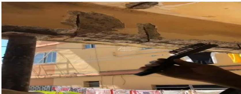
Figura 05 – Lixamento da armadura
