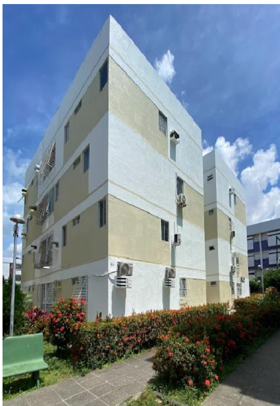
Figura 16 – Término da Revitalização de fachada
