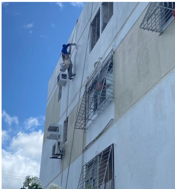
Figura 14 – Pintura de Fachada
