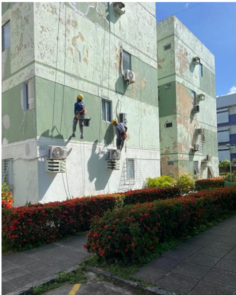
Figura 6 - Inspeção visual na Fachada B
