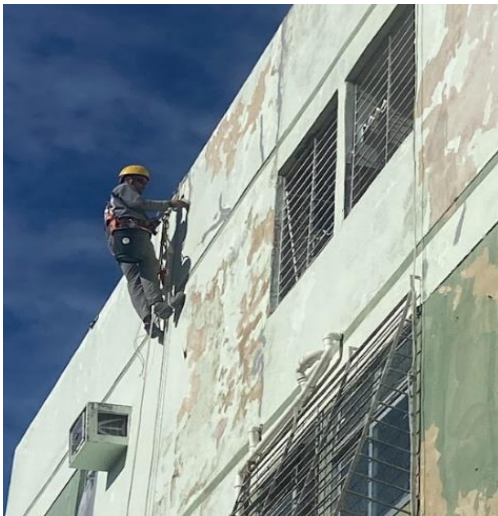
Figura 8 – Remoção de tinta desagregada e Abertura das trincas
