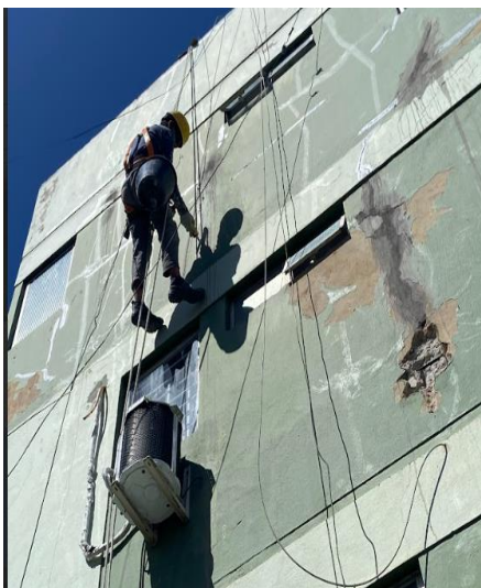
Figura 9 – Tratamento de fissuras
