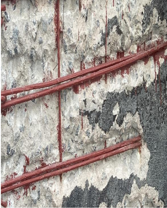
Figura 10 – Tratamento corrosão de armaduras
