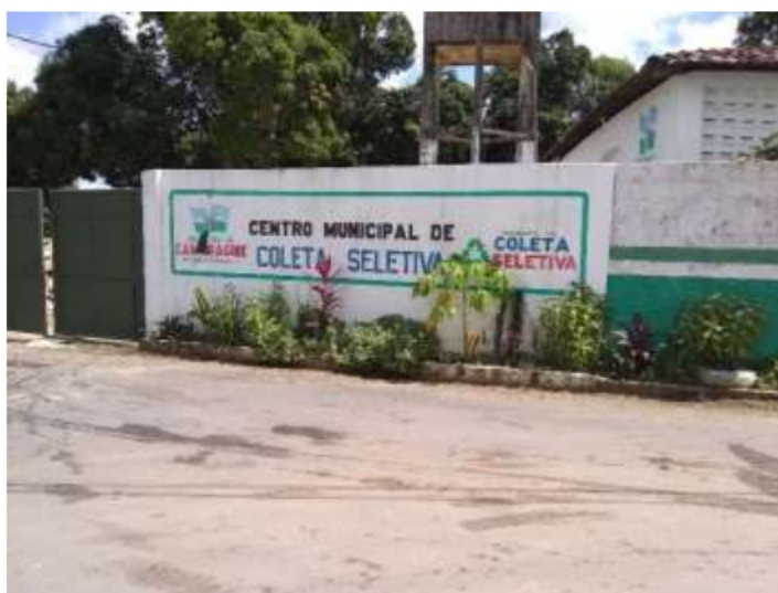
Figura 17 - Centro Municipal de Coleta Seletiva de Camaragibe.
