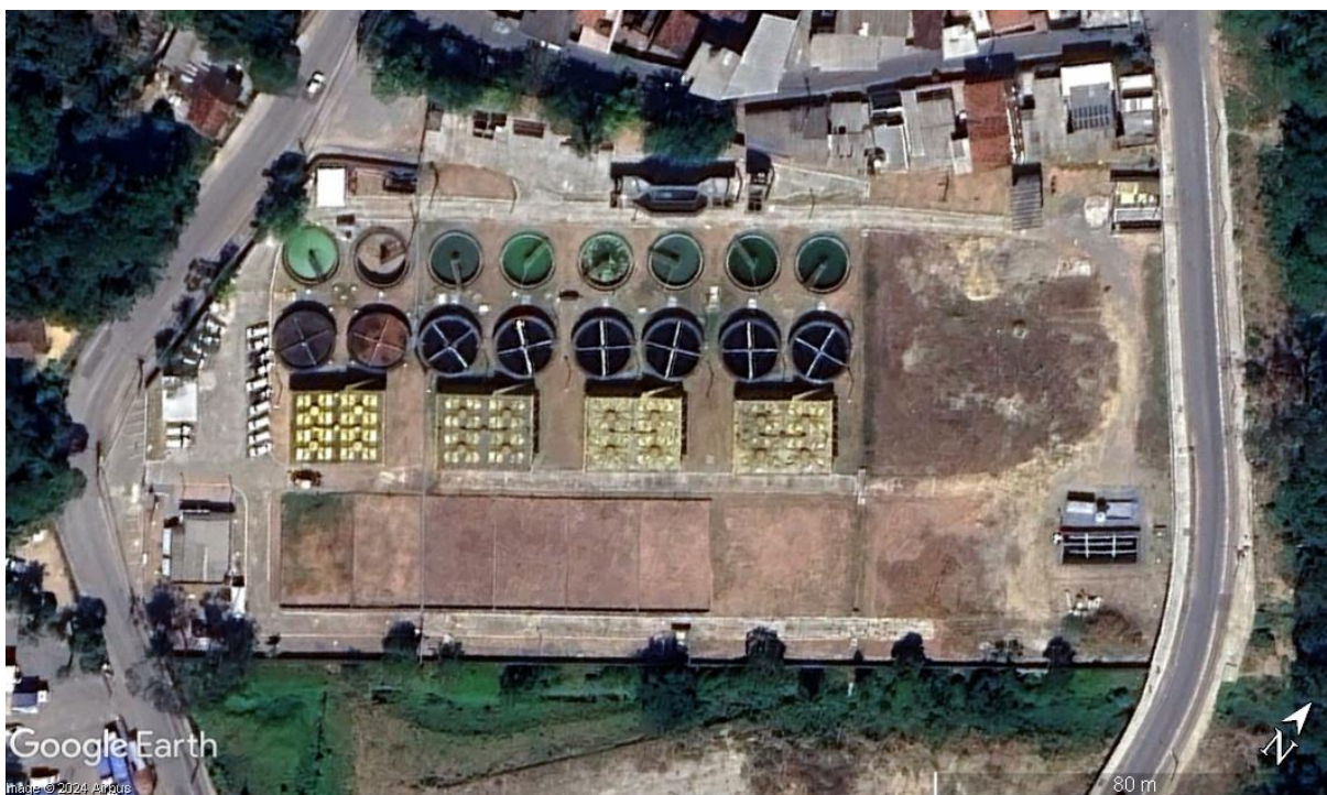
Figura 6 – Estação de tratamento de esgoto Minerva.
