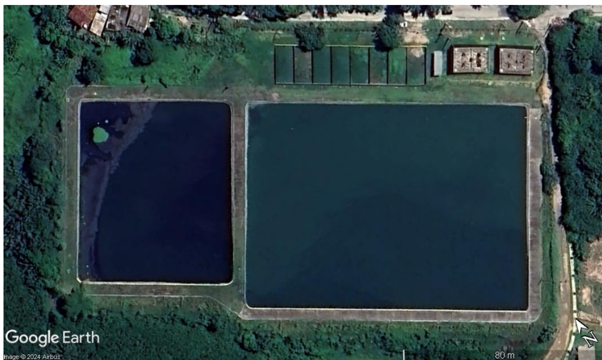
Figura 5 – Estação de tratamento de esgoto Gaibu.
