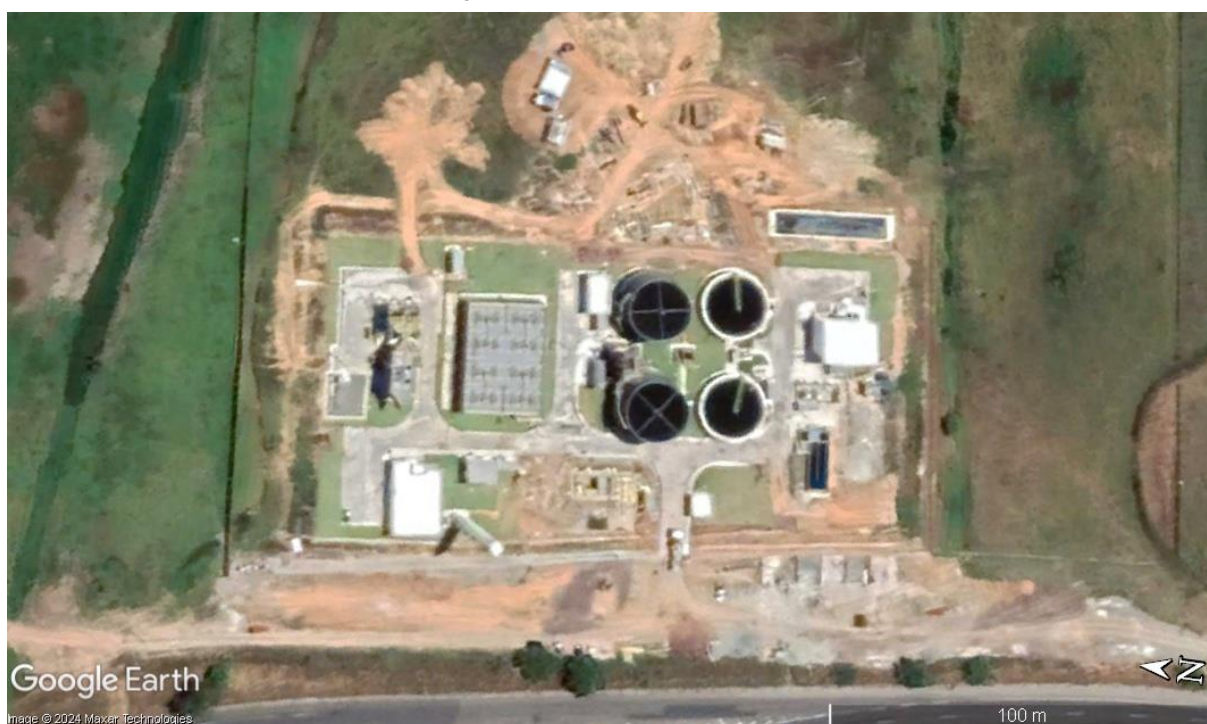
Figura 4 – Estação de tratamento de esgoto 10.01.
